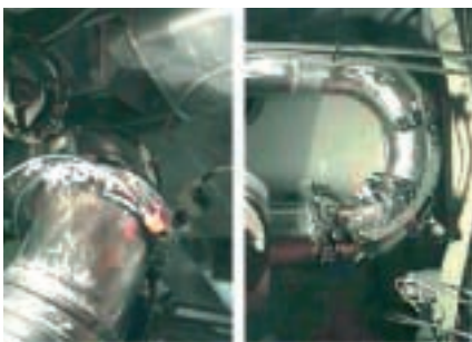
Der Computer steuert auch die automatisierte Rohrbogenprüfung im Kernkraftwerk.
